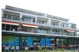
6 Läbesgarte, Biberist 39 appartements en location et en propriété par étages une 2 ème étape, est en construction. www.laebesgarte.ch
