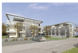
24 Gartenstrasse, Stein 30 appartements en propriété par étages standard Minergie®
