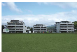
12 Sonnmatt, Küngoldingen 39 appartements en location et en propriété par étages, hôpital à côté www.sonn-matt-oftringen.ch
