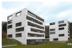
9 Beau-Site, Evilard 20 appartements en location et en propriété par étages standard Minergie® www.beausite-evilard.ch
